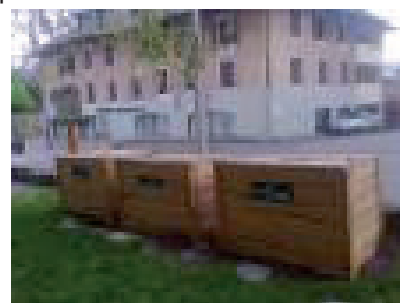
Les nouveaux bacs de la MJC
